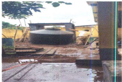
FOTO 6: Sustitución de deposito de agua.
