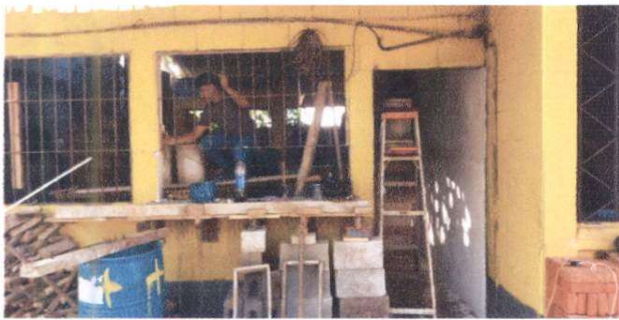
Foto 3: Mantenimiento de estructura de metal de ventanas.
