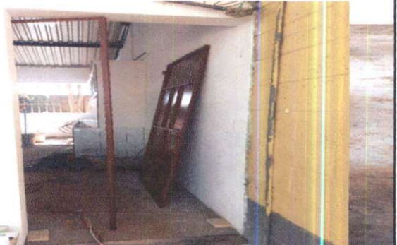
Foto 2: Sustitución de puerta de madera a puerta de metal.
