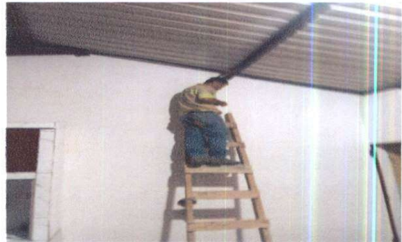
Foto 4: Instalación de energia electrica.
