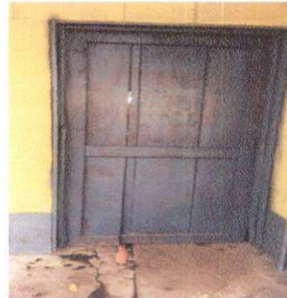
Foto 2: Sustitución de puerta de madera a puerta de metal.
