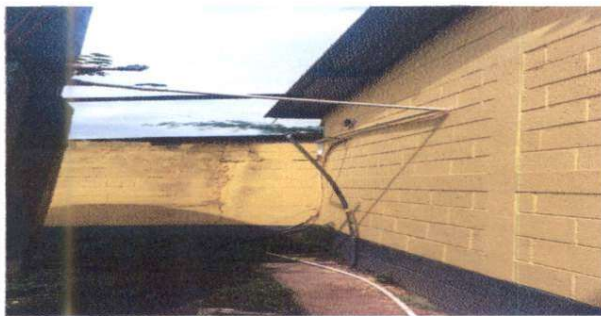
Foto 5: Sustitución de tubería lin
