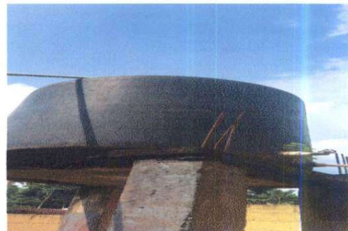
FOTO 6: Sustitución de deposito de agua.
