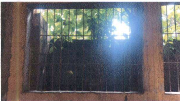
Foto 3: Mantenimiento de estructura de metal de ventanas.
