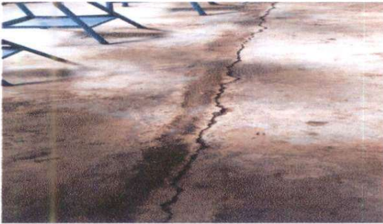
Foto 1: sustitución de torta de cemento a piso ceramico aula,
