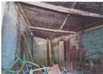
Foto 7: FOTOGRAFIA SUMINSITRO DE LAMINA CALIBRE 26 + ESTRUCTURUA METALICA
