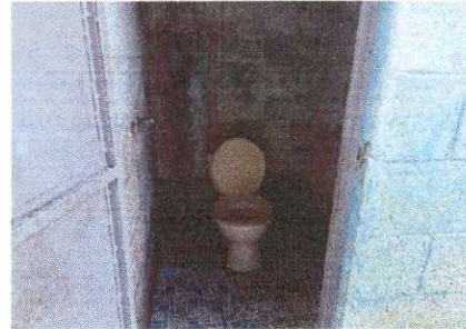
Foto 4: FOTOGRAFIA SUMINISTRO DE INODOROS + PINTURA
