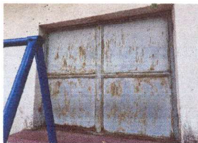
Foto 10: FOTOGRAFIA SUMINISTRO DE BALCON EN COCINA
