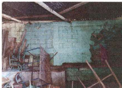
Foto 8: FOTOGRAFIA MEJORAMIENTO DE MURO EN LA COCINA
