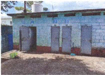
Foto 3: FOTOGRAFIA SUINISTRO DE PINTURA EN LAS PUERTAS DE LOS BAÑOS
