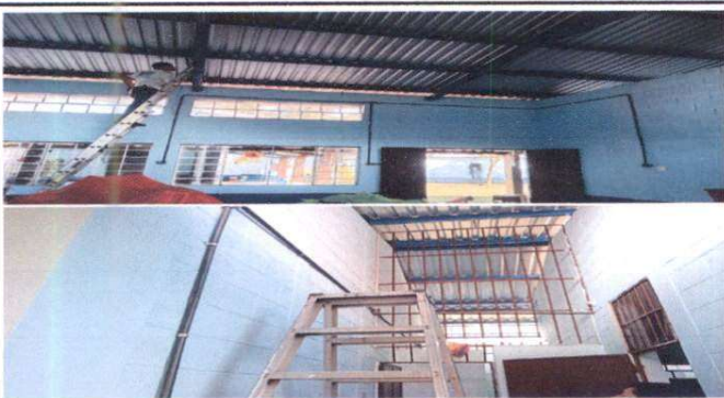
Cambio de sistema eléctrico
