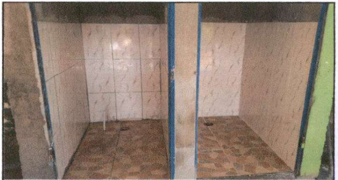
SUSTITUCIÓN DE PISO DE CONCRETO POR PISO ANTIDESLIZANTE
