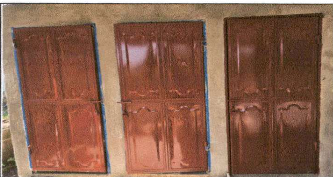
MANTENIMIENTO DE PUERTAS
