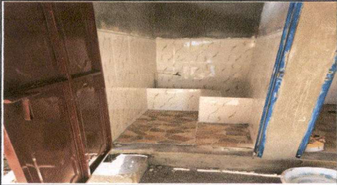
SUSTITUCIÓN DE ACCESORIOS PARA BAÑOS
