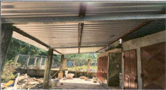
SUSTITUCIÓN DE CUBIERTA DE LÁMINA
