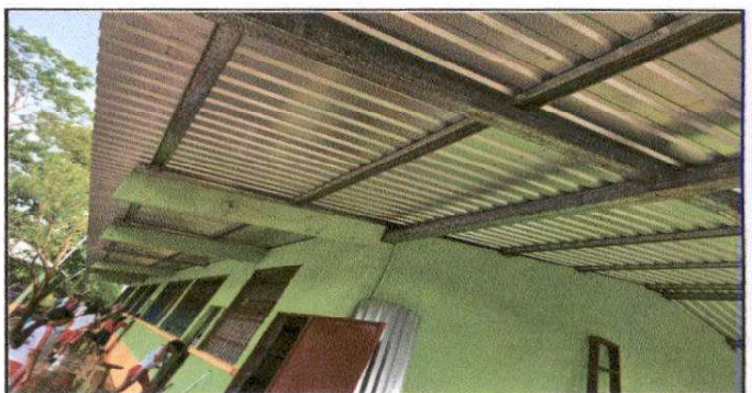
SUSTITUCIÓN DE COSTANERAS
