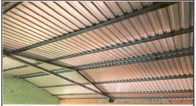
SUSTITUCIÓN DE CUBIERTA DE LÁMINA
