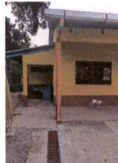
Foto 4: Terminación de instalación de canal y bajada de agua pluvial.
