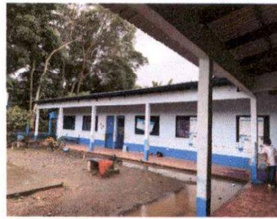
Foto 4: Falta de canal y bajada de agua pluvial.
