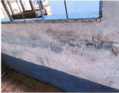
Foto 1: Paredes deterioradas, pintura en mal estado
