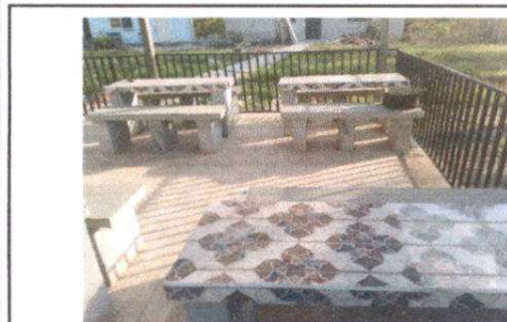
Foto 5: Sustitución de piso y de asulejo en las mesas.
