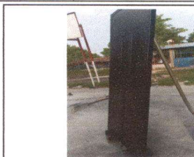
Foto 2: Mantenimiento de puertas.
