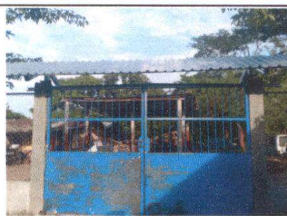
Foto 4: Mantenimiento en el portón de la entrada, ya que se el soporte que tenía no era el adecuado y se desprendió.
