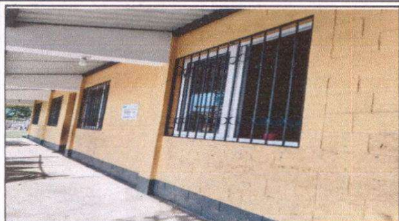
Foto 1: Reparación de sistema eléctrico en corredores.
