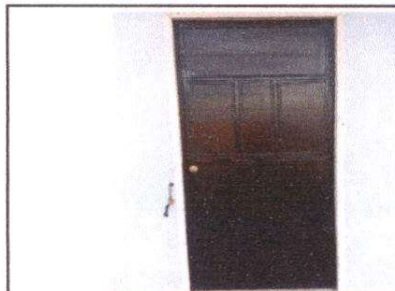
Foto 6: Sustitución de puerta.
