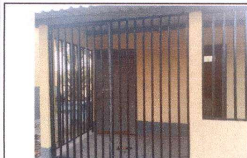
Foto 3: Mantenimiento de baranda en el contorno de los baños.
