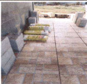
Foto 5: Sustitución de piso y de asulejo en las mesas.
