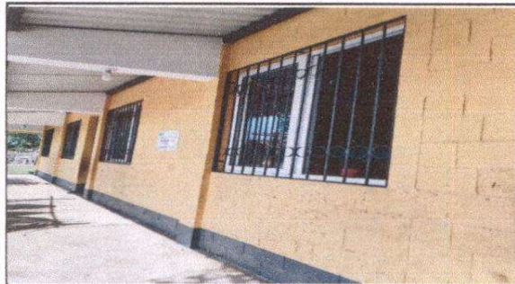
Foto 1: Reparación de sistema eléctrico en corredores.
