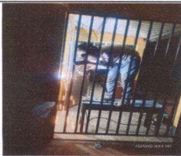
Foto 3: Mantenimiento de baranda en el contorno de los baños.
