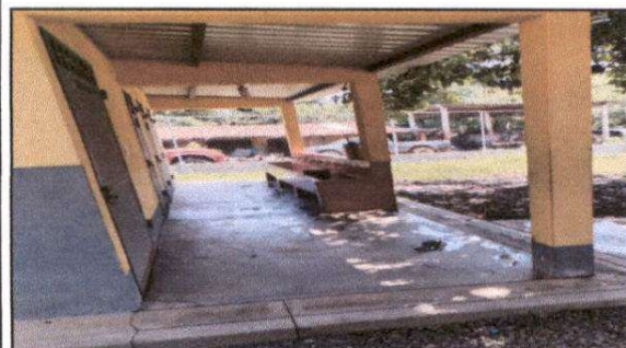
Foto 3: Mantenimiento de baranda en el contorno de los baños.
