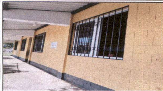
Foto 1: Reparación de sistema eléctrico en corredores.
