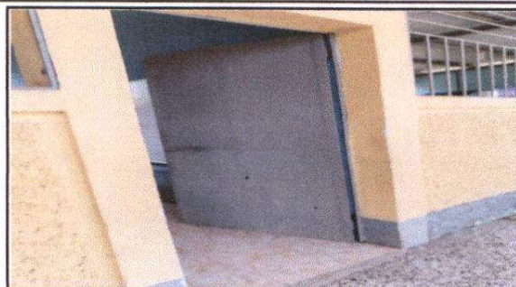
Foto 2: Mantenimiento de puertas.
