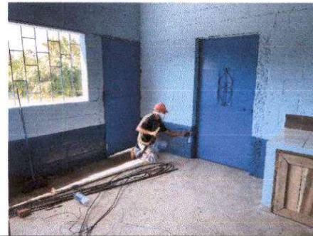
Foto 8: Mantenimiento de puerta de metal 0.90 x 2.10 de cocina
