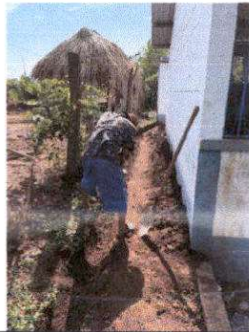
Foto 7: Suministro de banqueta de concreto para Sanitario
