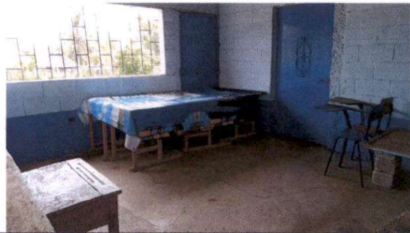
Foto 8: Mantenimiento de puerta de metal 0.90 x 2.10 de cocina
