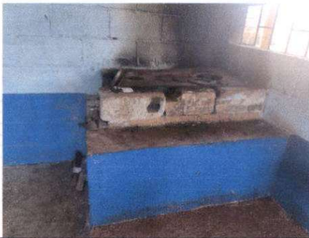
Foto 9: Sustitución de polletón por estufa rural de 2.00 mts x 0.70 mts en Cocina
