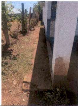
Foto 7: Suministro de banqueta de concreto para Sanitario
