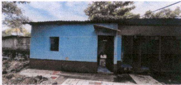
Sustitución de lámina en cocina.
