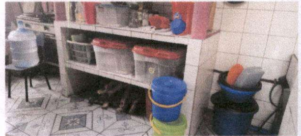
Reparación de azulejo en mueble de cocina
