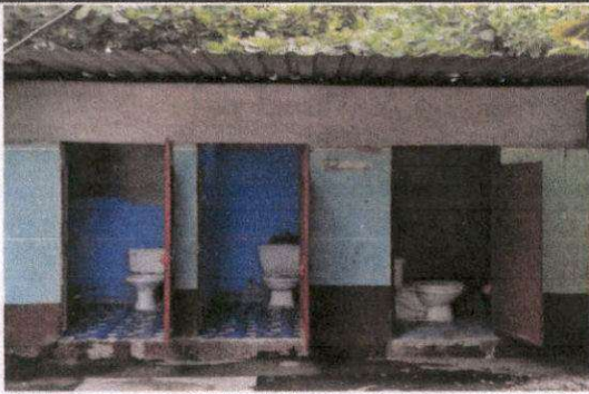
Sustitución de lámina. Sustitución de inodoro. Reparación del Sistema Eléctrico.
