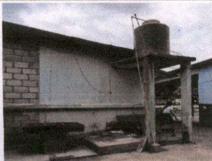
Reparación de depósito de agua.
