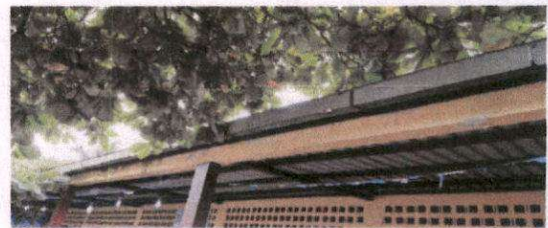
Sustitución de bajada de agua pluvial de metal por tubo PVC "3" en modulo I
