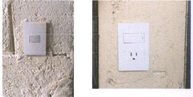
Foto 26: Sustitución interruptores dobles
