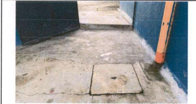
Foto 7: Sustrucción de torta de concreto.
