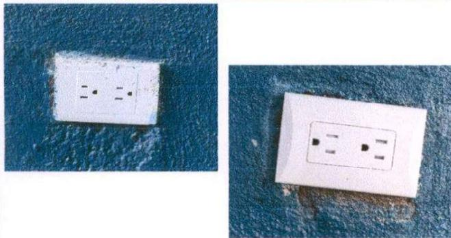
Foto 27: Sustitución tomacorriente dobles
