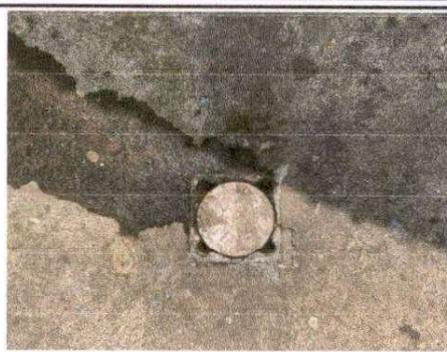
Foto 20: Sustitución de reposadera
