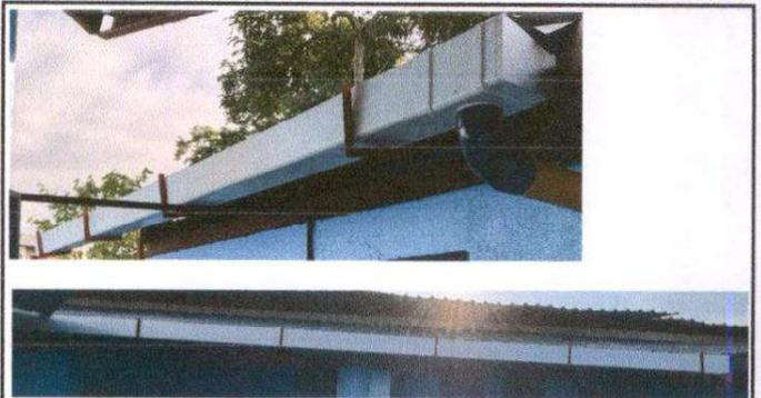
Foto 8: Sustrucción de canal de PVC.
