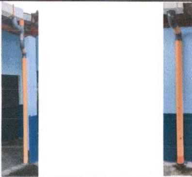
Foto 9: Sustrucción de bajada de agua pluvial tubo PVC 3".
