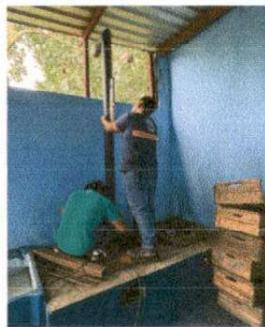
Foto 29: Sustitución chimenea de metal
