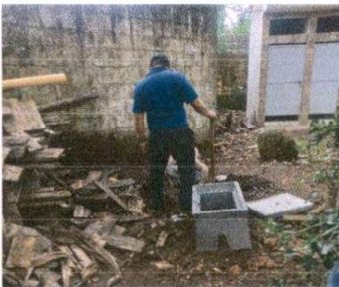
Foto 23: Sustitución caja de contador
