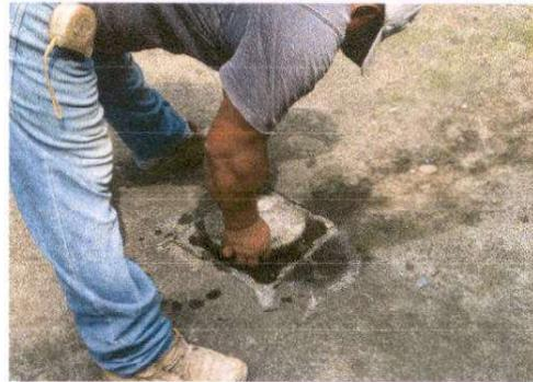
Foto 20: Sustitución de reposadera
