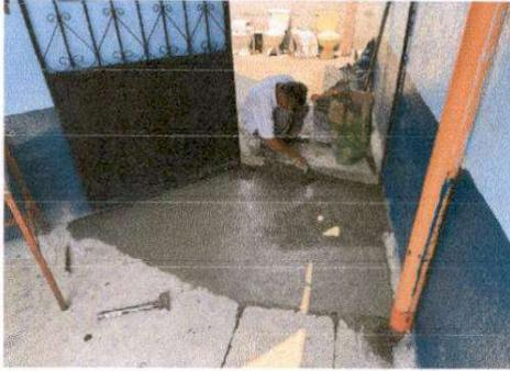
Foto 7: Sustrucción torta de concreto.
