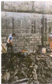
Foto 15: Reparación de muro perimetral de block con tubo hg y malla galvanizada, soleras intermedias y columnas.
