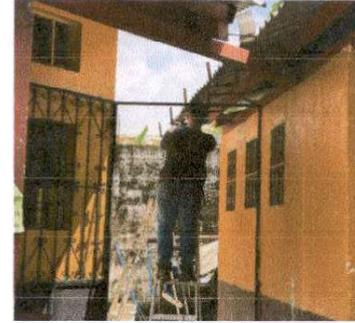
Foto 8: Sustrucción de canal de PVC.
