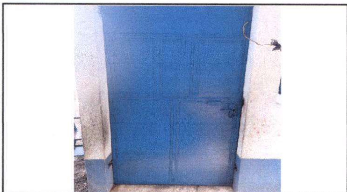
Foto 3: Sstitución de puerta
