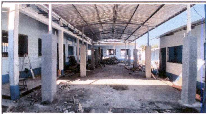
Foto 2: Sustitución de columnas de concreto amado.
