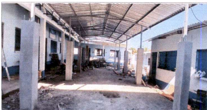
Foto 6: Suministro de columnas de concreto.
