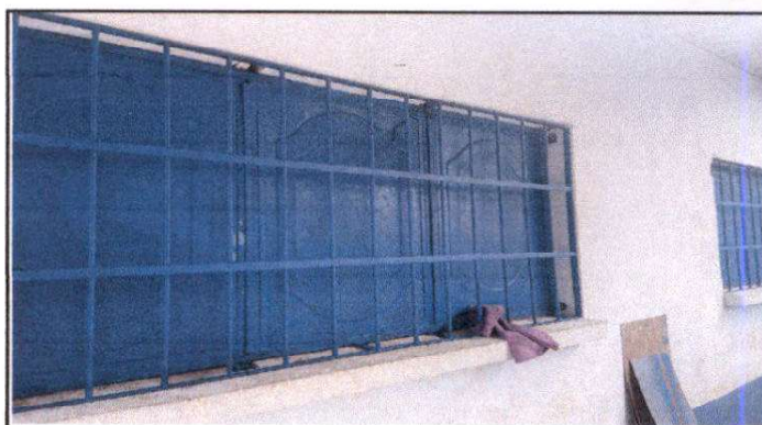
Foto 4: Suministro de ventanas de metal.
