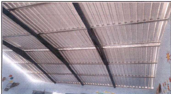
Foto 1: Sustitución de soporte de techo.
