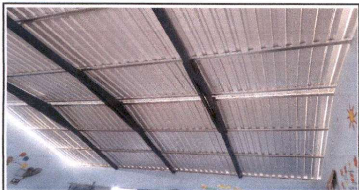
Foto 5: Sustitución de soporte de techo.
