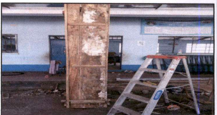
Foto 6: Suministro de columnas de concreto.
