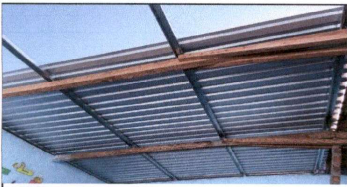
Foto 5: Sustitución de soporte de techo.
