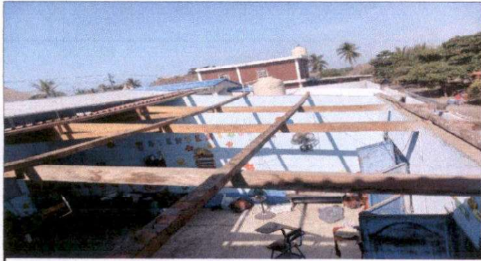
Foto 1: Sustitución de soporte de techo.
