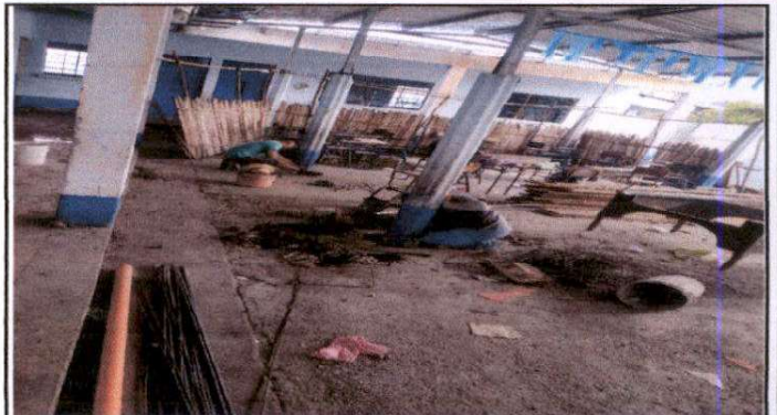
Foto 2: Sustitución de columnas de concreto amado.
