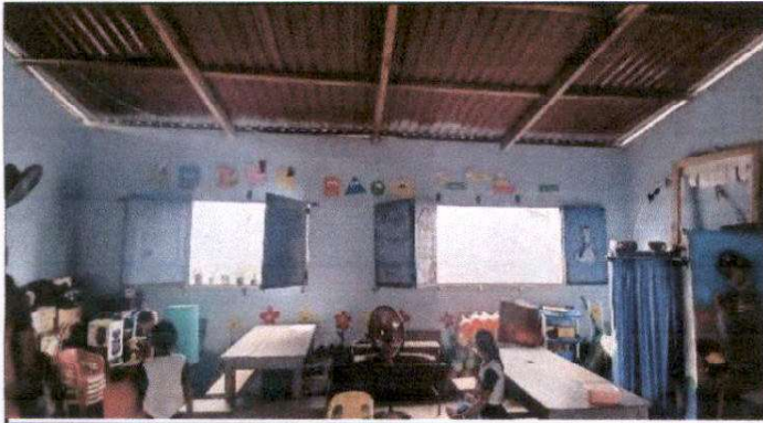
Foto 1: Sustitución de soporte de techo.
