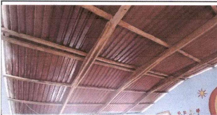
Foto 5: Sustitución de soporte de techo.
