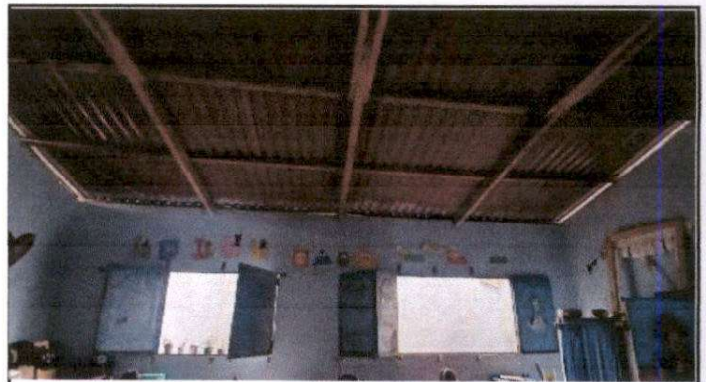
Foto 4: Suministro de ventanas de metal.
