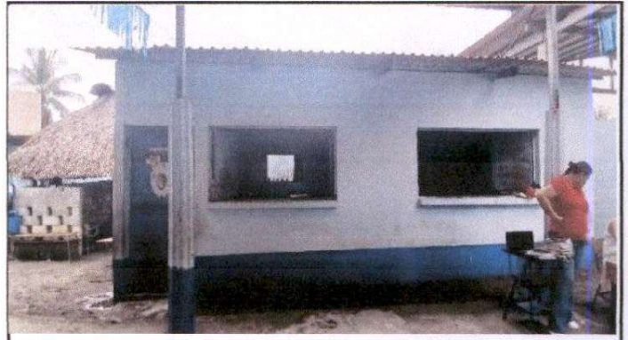
Foto 2: Sustitución de columnas de concreto amado.
