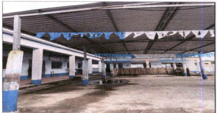
Foto 6: Suministro de columnas de concreto.
