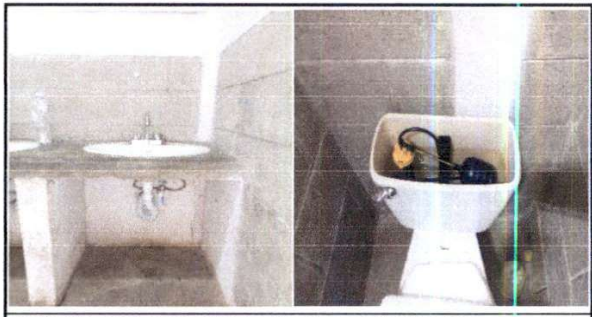
F.6 Sustitución de accesorios en 2 lavamanos y en 1 inodoro.
