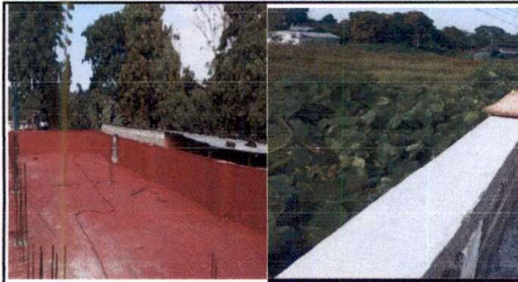
F.1 Suministro de solera de concreto armado de 0.15 x 0.20 metros con marquesina y gota de cenefa, reparación de pared con suministro de cernido monocapa e impermeabilización de pared exterior e interior.
