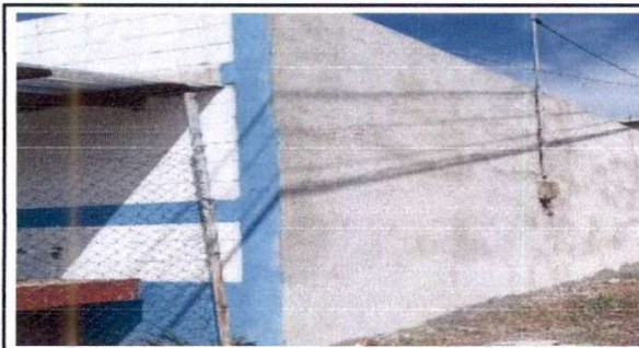
F.3 Impermeabilización de pared exterior en parte posterior de aulas y cara interna de aulas con presencia de humedad y sellado de junta de construcción entre módulo de gradas.
