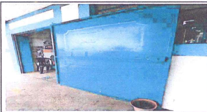
Mantenimiento de puertas de metal
