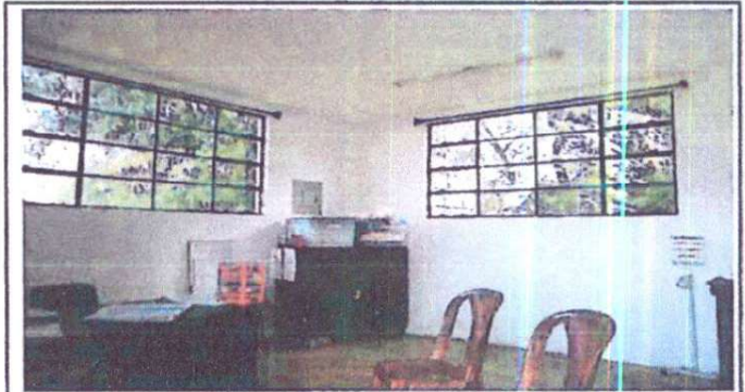
Suministro de balcón de estructura metálica
