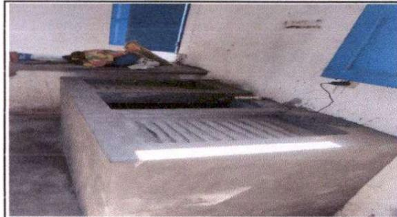
Foto 4. Sustitución de pila de plástico por pila de concreto.
