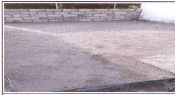
Foto 6. Torta de concreto en cocina exterior.
