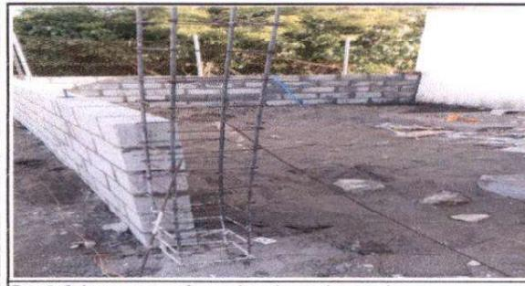
Foto 5. Columnas para refuerzo de techo, cocina exterior.
