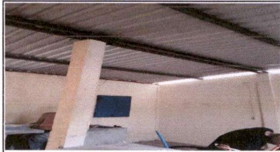
Foto 2. Sustitución de lámina troquela.
