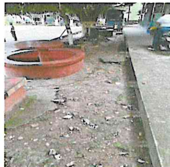
Foto 2: Losa de patio en frente de módulo 2.
