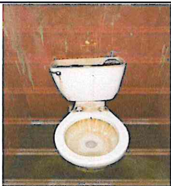
Foto 3: Sustitución de inodoros.
