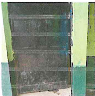
Foto 5: Remozamiento de puertas.
