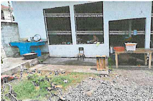
Foto 3: Losa de patio frente a la cocina.
