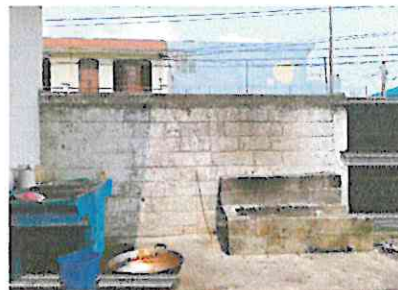
Foto 6: Ampliación de techo de cocina.
