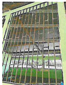
Foto 4: Remozamiento de los balcones.
