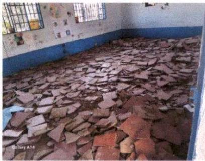
Foto 3: Levantado de piso para colocar piso ceramico.
