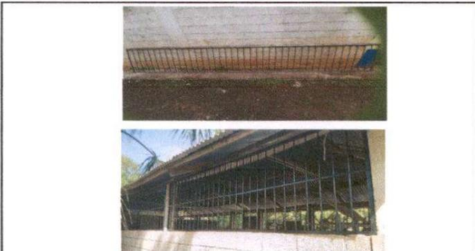
FABRICACION E INSTALACION DE BALCON CON HIERRO CON HIERRO 3/8, CON ANGULAR DE 1\*1CHAPA 16 MAS PINTURA ANTICORROSIVA NEGRO INCLUYE MANO DE OBRA.
