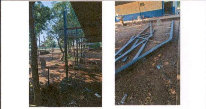
SUSTITUCION DE ESTRUCTURA DE MADERA POR ESTRUCTURA DE METAL COSTANERA 3\*2 CHAPA 16
