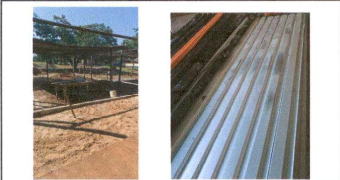
SUSTITUCION DE LAMINA POR LAMINA CALIBRE 26 TROQUELADA, MODULO DE AULA EXTERIOR
