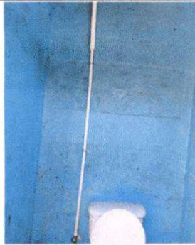
Foto 3: Sustrucción de sistema de abastecimiento de agua en servicios sanitarios
