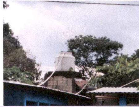
Foto 2: Sustrucción de depósito de agua de 750 litros incluye accesorios, sustitución de tubería de abastecimiento de agua.
