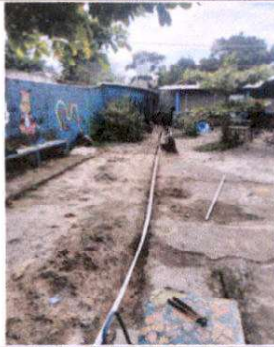
Foto 1: Sustrucción de losa de patio de concreto
