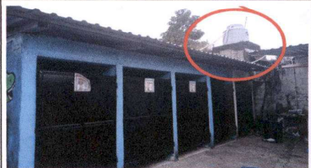
Foto 2: Sustrucción de depósito de agua de 750 litros incluye accesorios, sustrucción de tubería de abastecimiento de agua.
