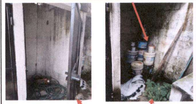
Foto 4: Suministro de dos inodoros infantiles en servicios sanitarios, suministro de puerta de meta, suministro de tubería para abastecimiento de agua y aplicación de pintura en muros.
