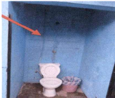
Foto 3: Sustrucción de sistema de abastecimiento de agua en servicios sanitarios
