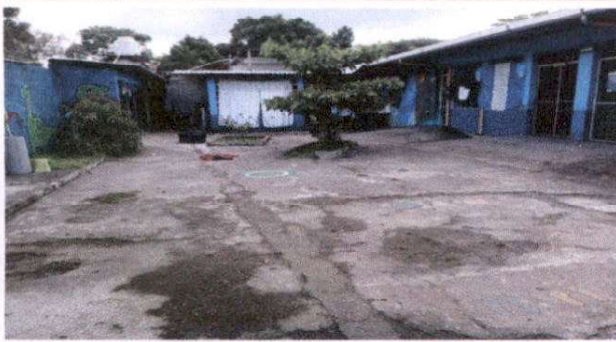
Foto 1: Sustrucción de losa de patio de concreto
