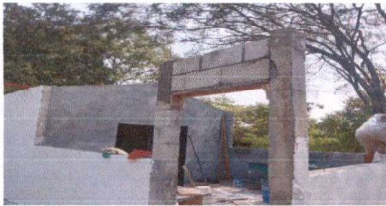
FOTO 3. Cernido y Repello , interior y exterior de cocina.
