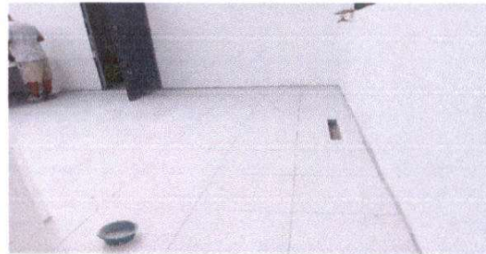
FOTO 4. Sustitución de piso de cemento por ceramico.
