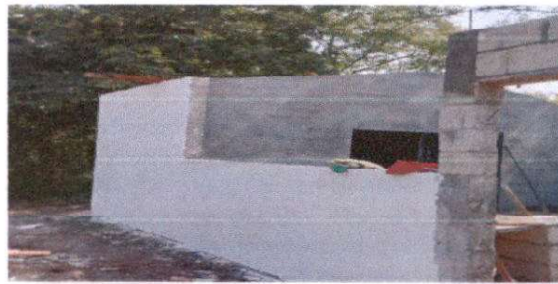
FOTO 2. Sustitución de laminas.
