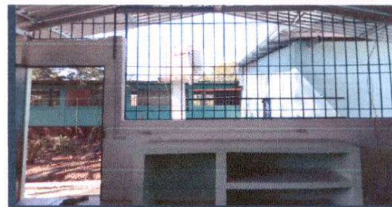
FOTO 6. Sustitución sistema electrico.
