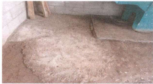
FOTO 4. Sustitución de piso de cemento por ceramico.
