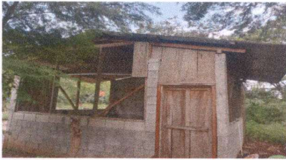
FOTO 1. Sustitución de dos puertas de madera por puertas de metal.
