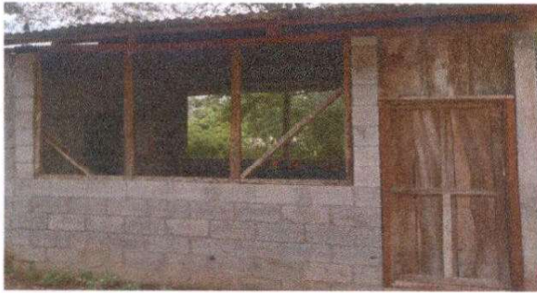
FOTO 3. Cernido y Repello , interior y exterior de cocina.
