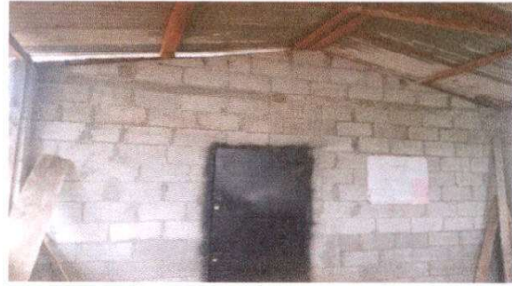
FOTO 2. Sustitución de laminas.
