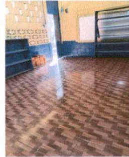
Foto 2 Sustrucción de piso de concreto por piso ceramico
