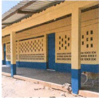
Foto 1: Sustrucción de puerta de madera por puerta de metal con marco (3.10x1.00 incluye mano de obra)
