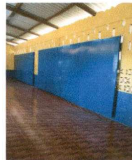
Foto 4: Sustrucción de porton interior de madera por porton de metal con rodo 5.00 x2.30 (incluye mano de obra)
