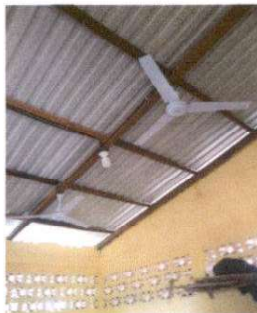
Foto 5: Sustrucción de tomacorriente por tomacorriente (incluye cable, ducto vinil, curva, uniones y cinta de aislar)
