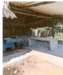
Foto 6: Sustrucción de polleton por estufa rural completa con parrilla y chimenea2.00 mts.x0.70 mts (incluye mano de obra)
