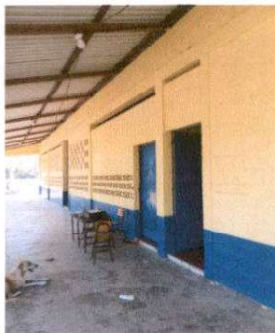
Foto 3: Aplicación de pintura en muro interior y exterior
