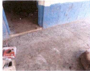
Foto 2 Sustitución de piso de concreto por piso ceramico
