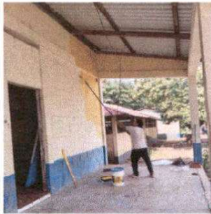
Foto 3: Aplicación de pintura en muro interior y exterior
