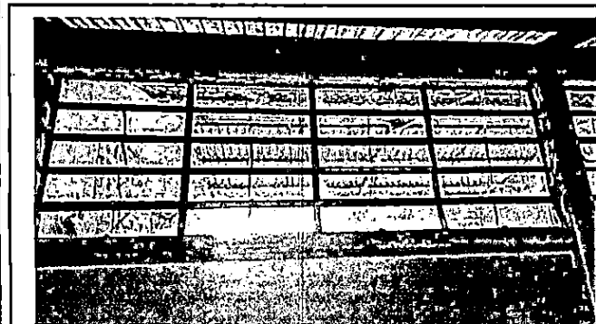
VENTANALES DE METAL CON VIDRIO QUE SERAN SUSTITUIDOS
