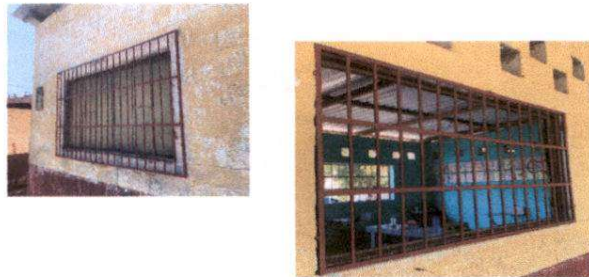
FOTO 4: Mantenimiento de Balcones
