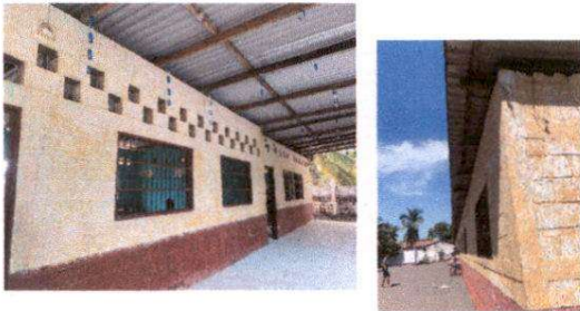
FOTO 3: Aplicación de Pintura en Muros Exteriores
