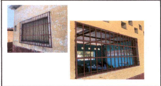
FOTO 4: Mantenimiento de Balcones
