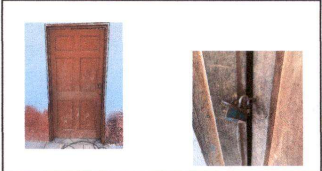
FOTO 2: Mantenimiento de Puertas, ventanas y cambio de Chapas
