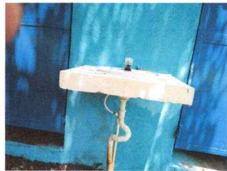
Foto 6: Instalación de lavamanos
