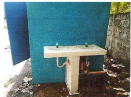
Foto 12: Sustrucción de lavamanos
