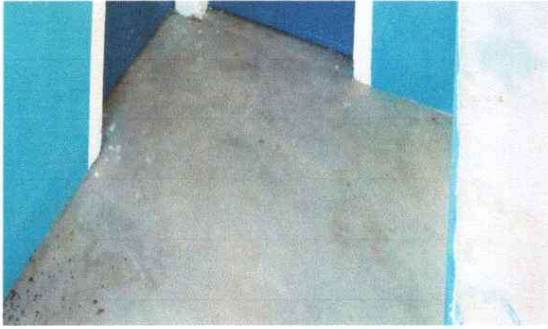
Foto 7: Sustrucción de piso
