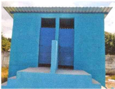
Foto 11: Sustrucción de puerta
