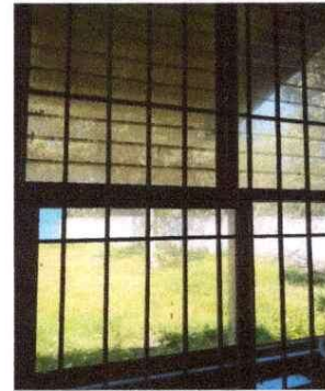
Foto 2: Instalación de balcones
