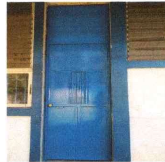
Foto 4: Sustitución de puerta de madera por puerta de metal
