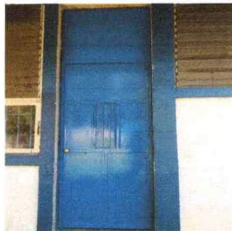
Foto 3: Sustitución de puerta de madera por puerta de metal
