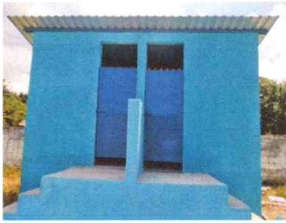
Foto 3: Sustitución e instalación de puertas
