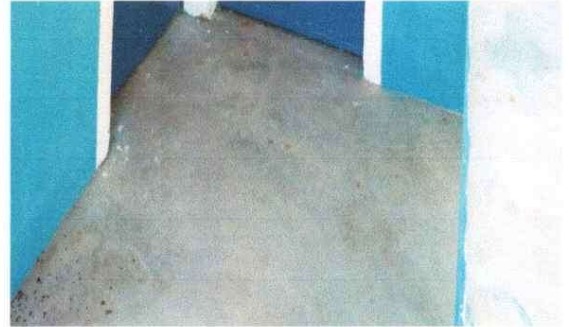
Foto 8: Sustrucción de piso
