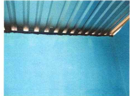
Foto 10: Sustrucción de lámina
