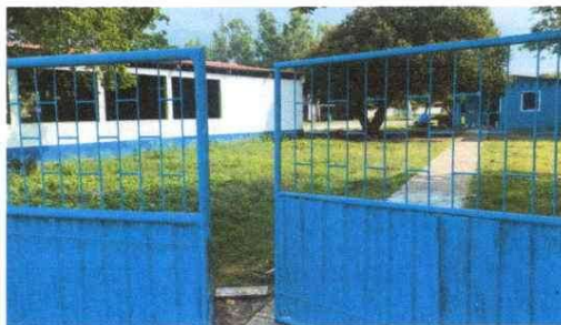
Foto 5: Mantenimiento de portón
