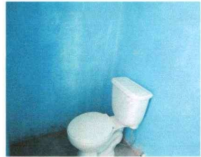
Foto 4: Sustitución de sanitarios
