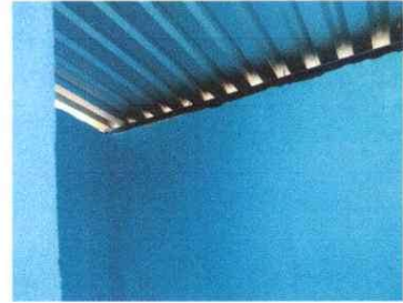
Foto 2: Repello exterior e interior
