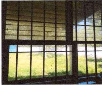
Foto 1: Instalación de balcones
