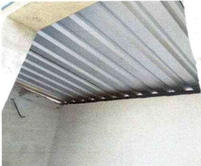
Foto 9: Sustitución de láminas
