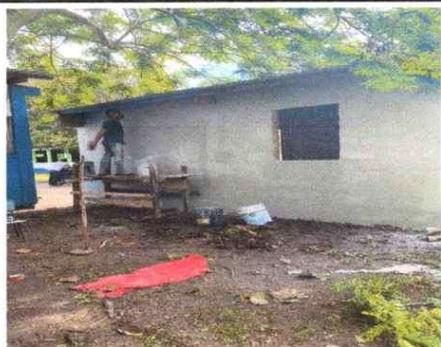
Foto 11: Repello y pintura exterior e interior
