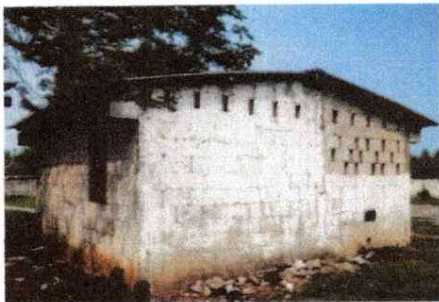
Foto 11: Repello y pintura exterior e interior
