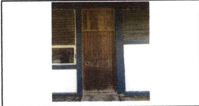
Foto 4: Sustitución de puerta de madera por puerta de metal
