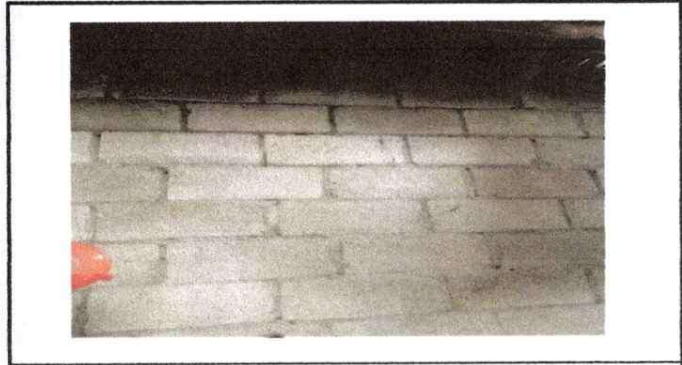
Foto 4: Demolación de pared existente más tallado
