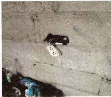
Foto 9: Sustitución de tomacorriente más iluminación
