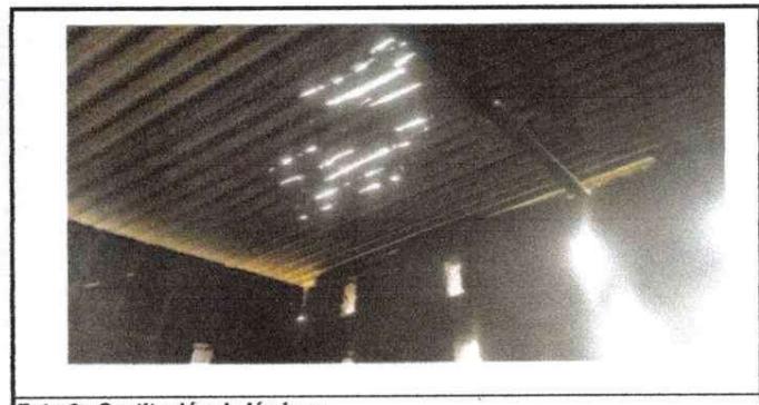
Foto 6: Sustitución de láminas
