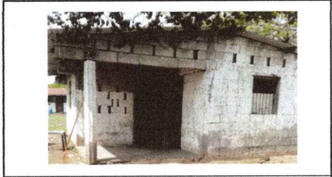
Foto 2: Repello y cernido en paredes interior y exterior
