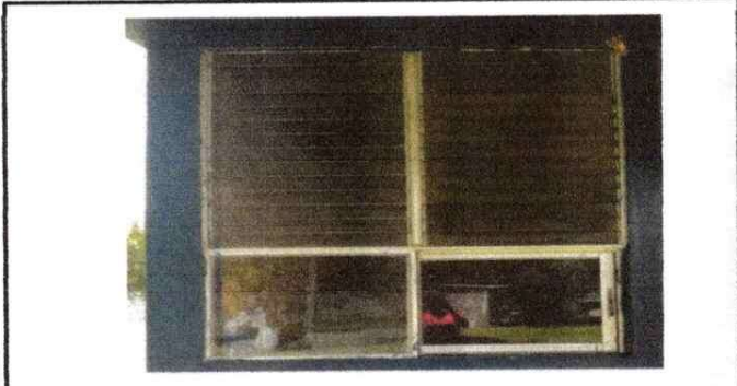
Foto 1: Instalación de balcones
