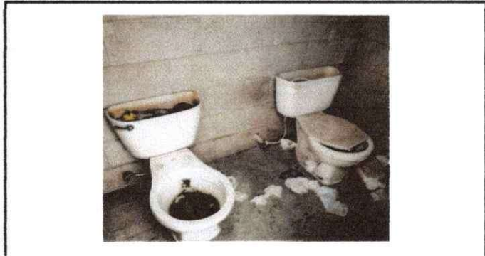
Foto 4: Sustitución de sanitarios
