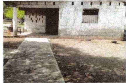
Foto 10: Instalación de ventana de metal
