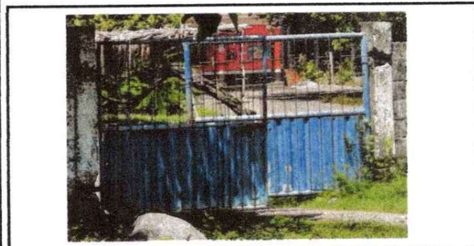
Foto 5: Mantenimiento de portón
