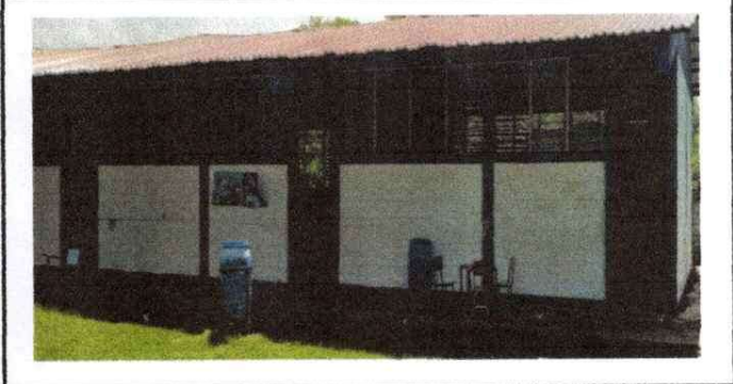
Foto 2: Instalación de balcones
