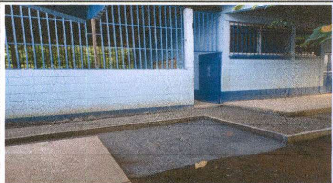
Suministro y fabricación de parrilla de metal
