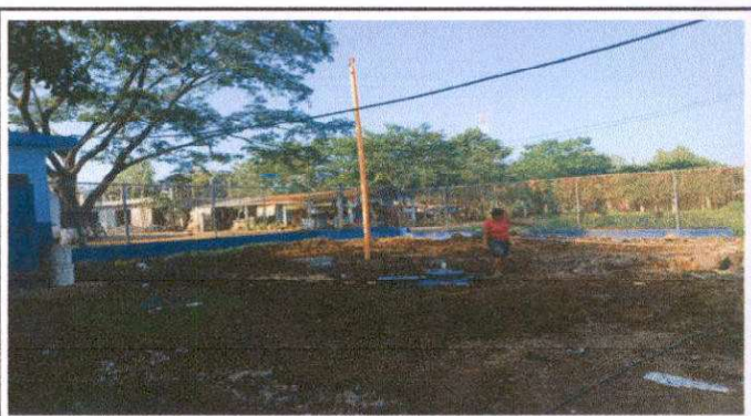
Suministro e instalación de biodigestor
