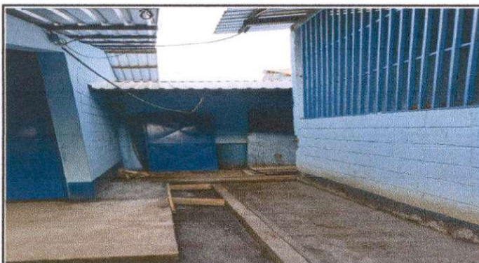
Suministro de cuneta de concreto
