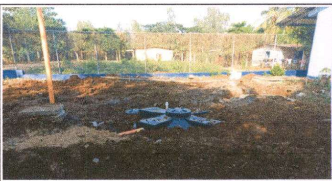
instalación de biodigestor con accesorios y tubería pvc
