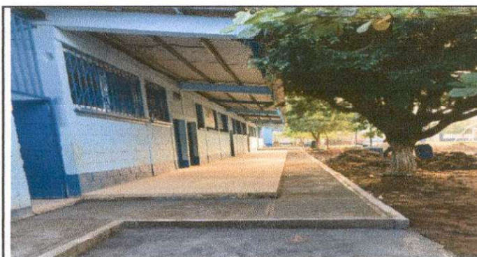
Suministro de base de concreto para banqueta de 1 metro de ancho x 40 mts de largo
