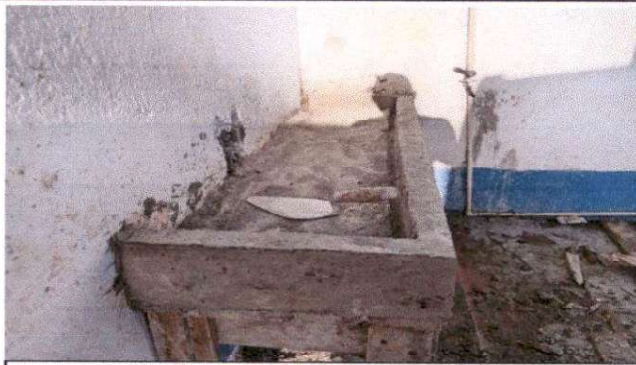
Foto 2: Suministro de lava mano de concreto.
