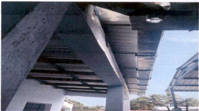
Foto 4: Canales y bajadas de agua cubiliales
