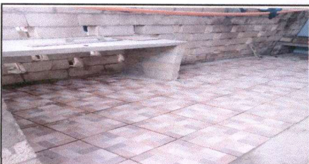
Foto 6: Remozamiento de cocina.
