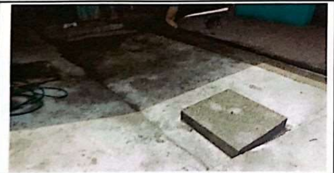
Foto 5: Remozamiento de fosa septica (extraccion de lodos)
