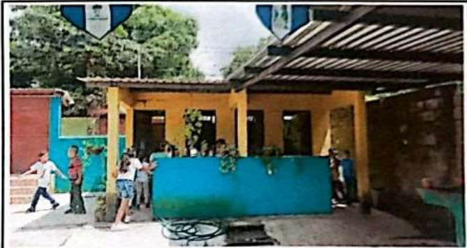
Foto 4: Remozamientos de puertas de metal
