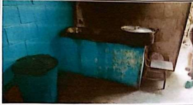
Foto 7: Demolición de estufa existente
