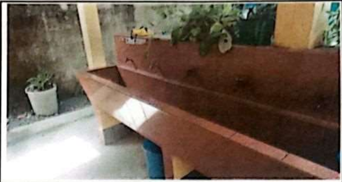
Foto 2: Cambio de llaves de lavamanos colectivo
