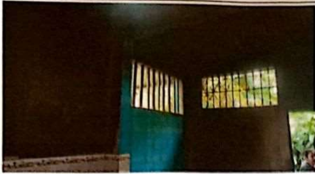
Foto 13: Pintura en muros
