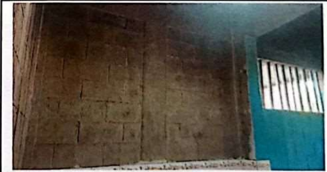
Foto 6: Demolicion de vanos para ventanas
