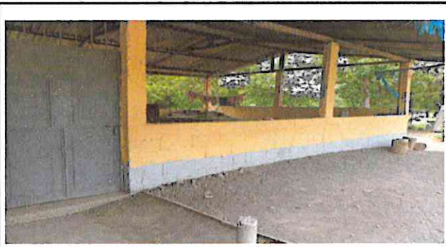
Foto 2: Sustitución de balcones de protección de toda el área de cocina
