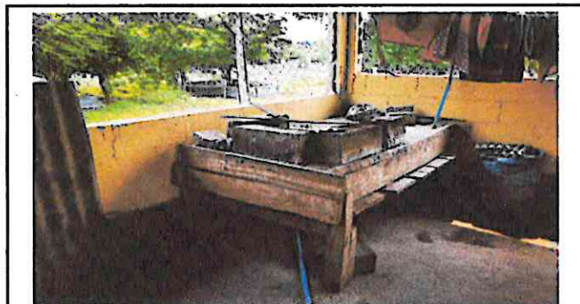
Foto 5: Sustitución de polleton de madera y tierra por block y ladrillo parrilla (1.00X1.80)
