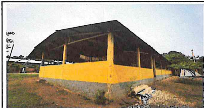
Foto1: Sustitución de cubierta de lámina por lámina troquelada Calibre 26
