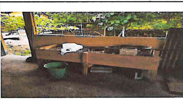
Foto 4: Sustitución de Polleton de madera y tierra por block y ladrillo plancha de metal (0.80x2.20)
