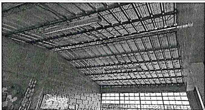
Instalación de sistema eléctrico
