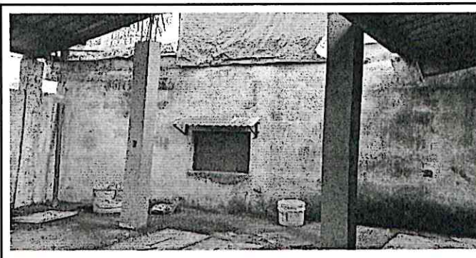
Construcción de pared
