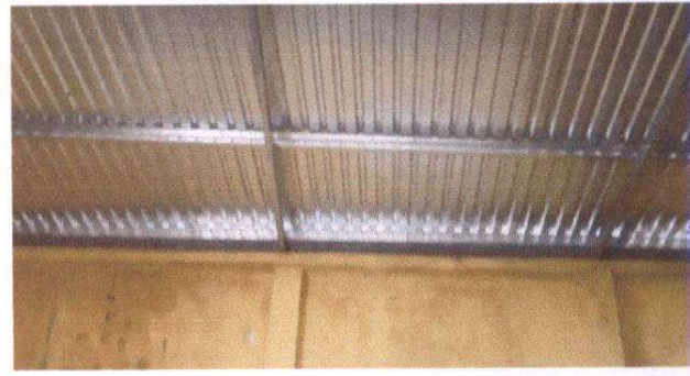
Foto 6: Sustitución de cubierta de lámina y estructura de soporte en aulas.
