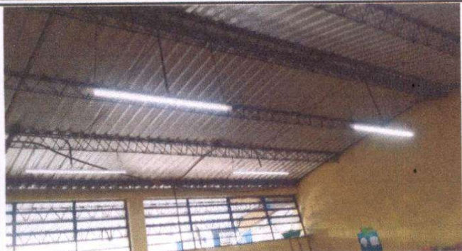
Foto 1: Reparación de sistema eléctrico
