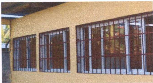
Foto 3: Suministro de puerta de metal de 1.0 X 2.10, Suministro de ventana PVC blanco con vidrio claro.
