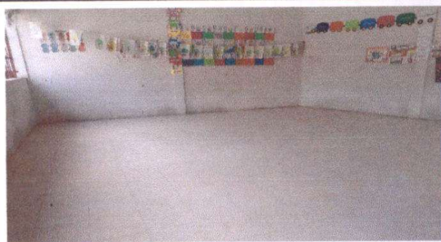
Foto 2: Sustitución de Piso líquido por piso cerámico en aula.
