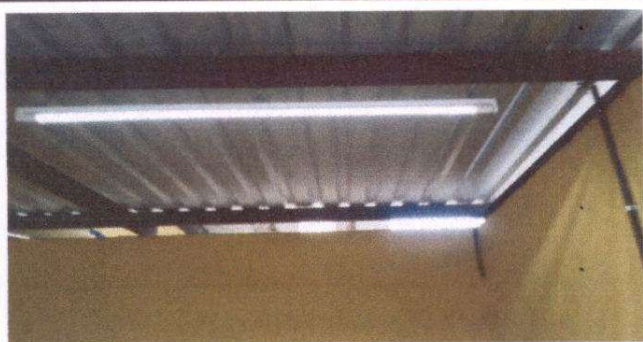
Foto 5: Reparación de sistema electricos en aulas.
