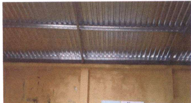
Foto 4: Sustitución de lámina troquelada calibre 26 Sustitución de estructura de metal costanera 3*2 chapa 18 (Lijado y pintado)
