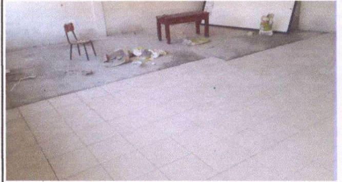
Foto 2: Sustitución de Piso líquido por piso cerámico en aula.
