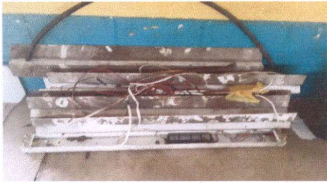
Foto 1: Reparación de sistema eléctrico
