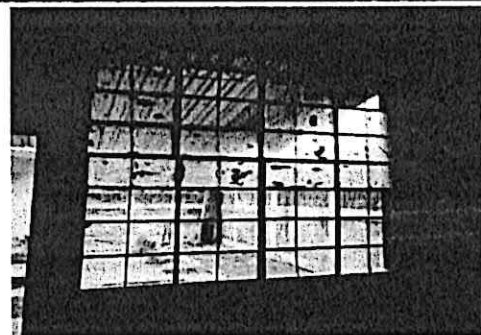
Mantenimiento y pintura de ventana existente
