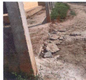
FUNDICION DE LOSA EN INGRESO
