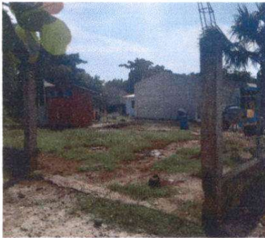
INSTALACION DE PORTON DE METAL
