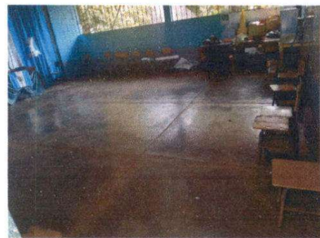
SUSTITUCION DE PISO DE CONCRETO POR PISO CERAMICO
