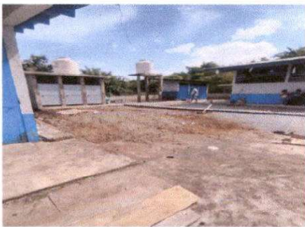
SUSTITUCIÓN DE PISO POR LOSA DE CONCRETO EN PATIO
