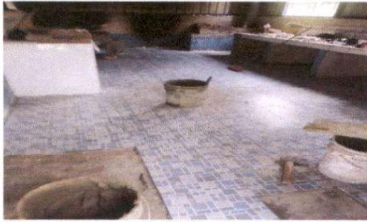
SUSTITUCIÓN DE TORTA DE CONCRETO POR PISO CERÁMICO ANTIDESLIZANTE
