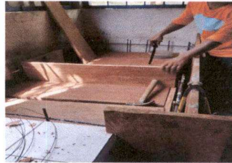
SUSTITUCIÓN DE PILA PREFABRICADA POR PILA DE CONCRETO FUNDIDO
