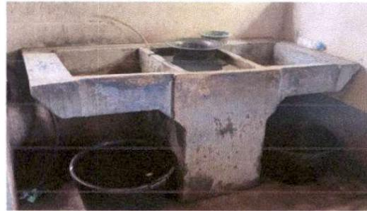
Foto 2: sustitución de pia prefabricada por concreto fundida
