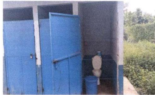
Foto 4: Sustitucion de 3 baños en mal estado, repello de paredes, azulejo, piso antideslizante, sustitución de puertas
