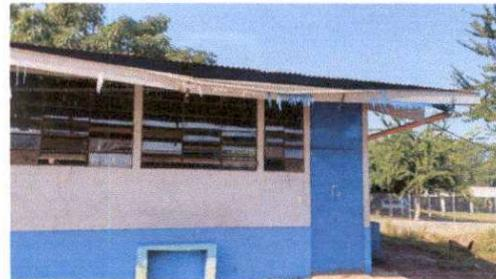
Foto 6 Sustitución de de canal en mal estado por canal pluvial nuevo
