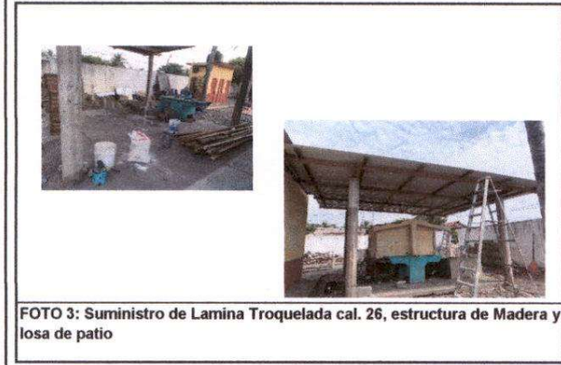
FOTO 1: Suministro de Lamina troquelada cal. 26 mas estructura de madera
