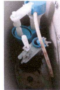
FOTO 4: Cambio de accesorios en inodoros
