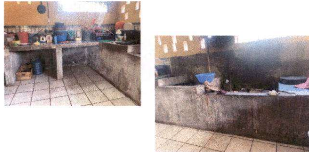
FOTO 2: Suministro de Gabinete, Polleton de Ladrillo y Azulejo
