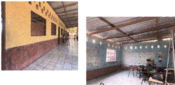
FOTO 5: Aplicación de Pintura de Interior y Exterior
