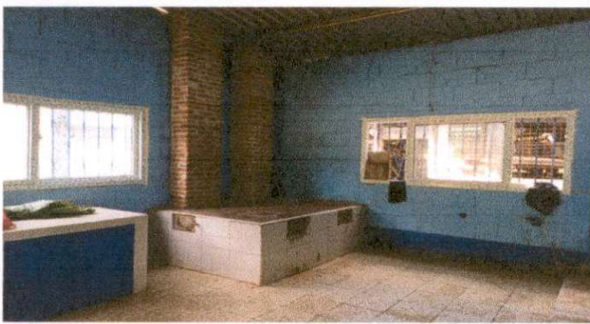
sustitución de ventanas de madera por ventana de pvc corredizas
