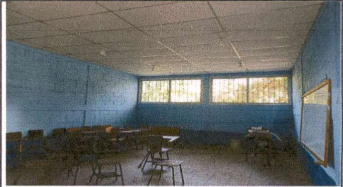
suministro e instalación de ventana pvc color blanco con vidrios claros
