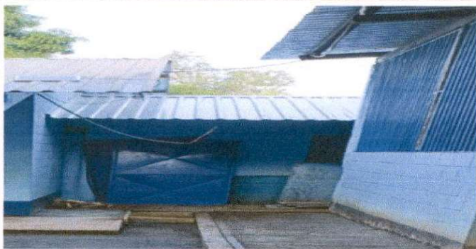
Suministro e instalación de cubierta de lámina
