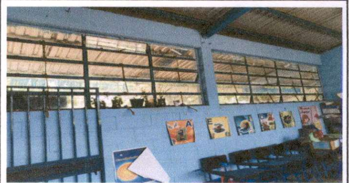
Suministro lijado y cepillado, dos manos de pintura en puerta de reja
