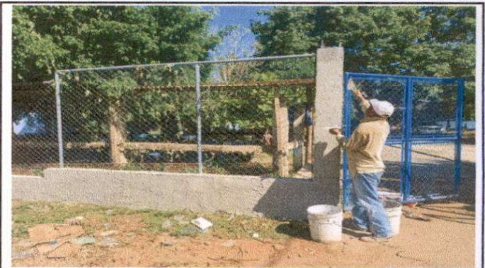
suministro de repello y cernido en muro perimetral
